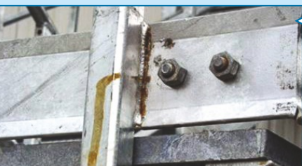
Kaynak kusması ve kaynak akıntısı
